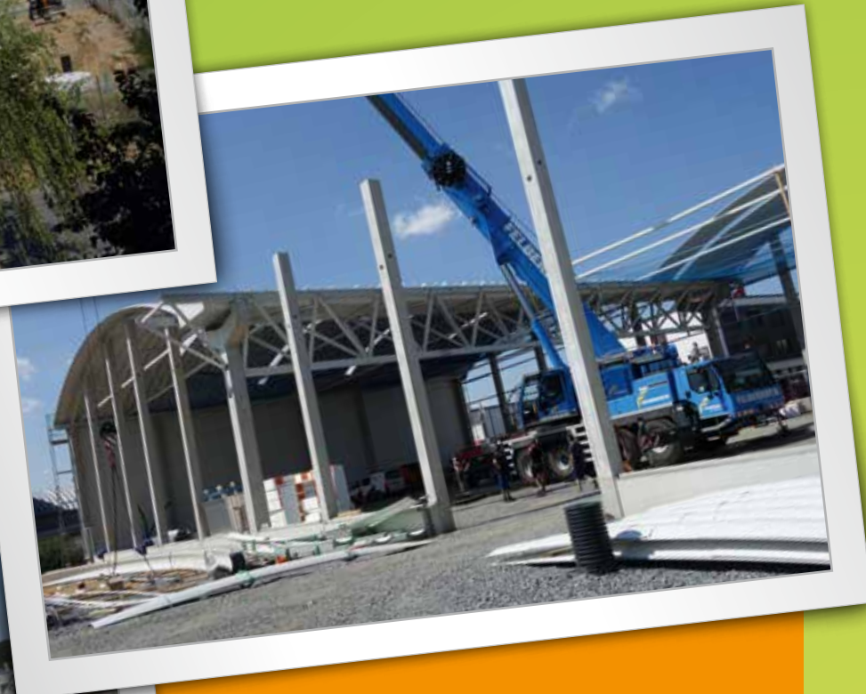
Die Halle ist 12,5 m hoch, 35 m breit und hat eine Fläche von 3.800 m 2 .
